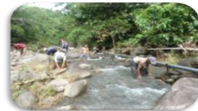
Gambar 3 Program CSR dalam pekerjaan Air Bersih
