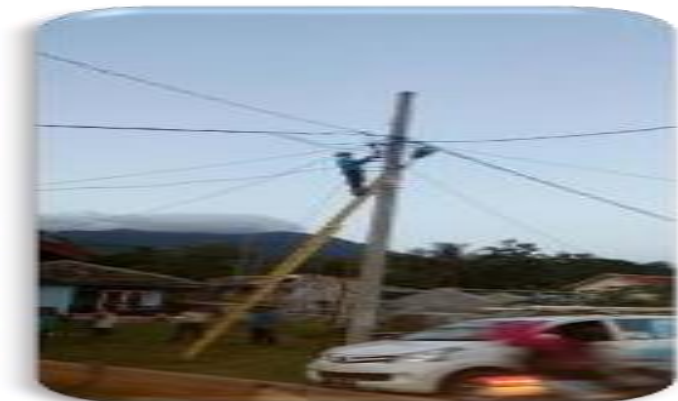
Gambar 2 Pelaksanaan program Pemasangan Jaringan Listrik
