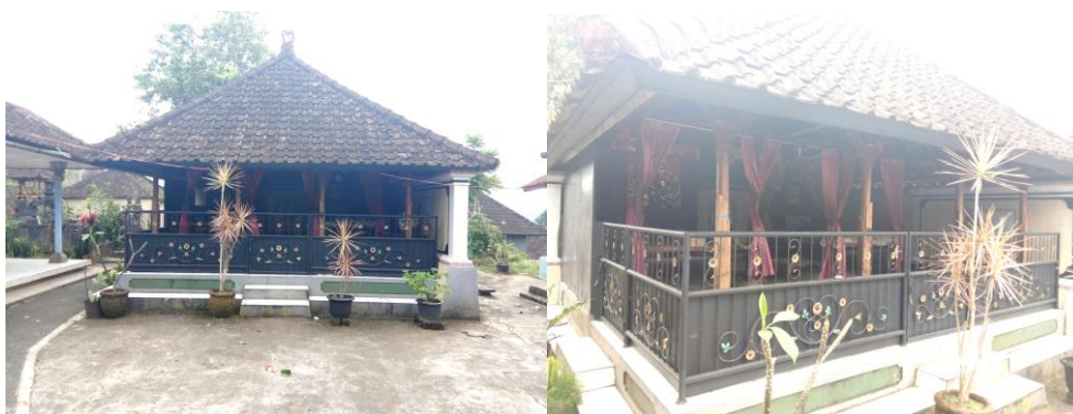
Gambar 14 Penambahan Dinding Semi Penyekat pada Bangunan Bale
