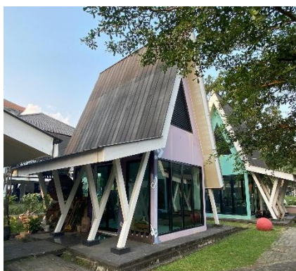
Gambar 4. Kondisi bangunan PAKSI
