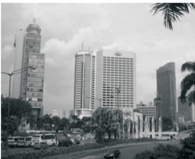
Gambar 05: Bangunan Modern dengan penerapan teknologi dalam mengantisipasi permasalahan iklim tropis lembab. (Sumber: Foto Gagoeck H)
