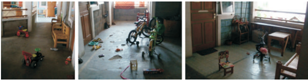
Gambar 16: Kerusakan fisik non permanen di rusunawa Cigugur (Sumber: survai 2012)
