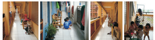
Gambar 18: Kerusakan fisik non permanen di rusunawa Cingised. (Sumber: survai 2012)
