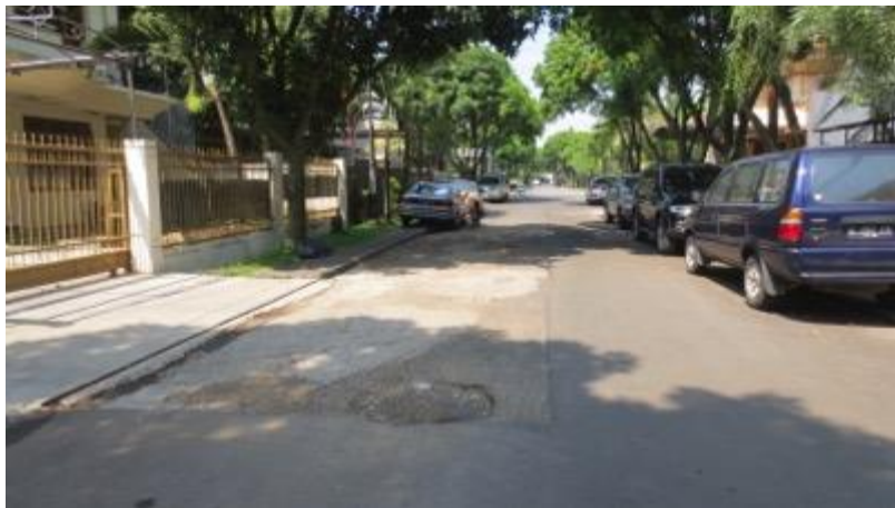
Gambar 1. Kondisi Jalan Perumahan Cluster E.
