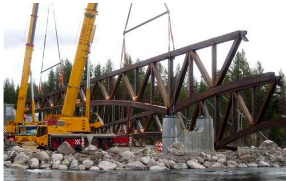
Gambar 1. Pekerjaan pembuatan jembatan konstruksi kayu
