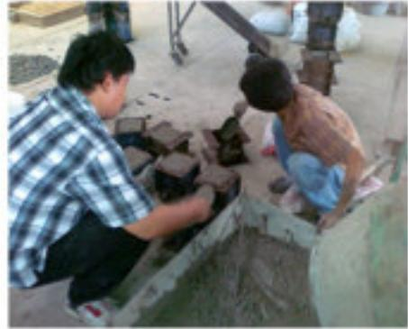
Gambar 8. Proses Penuangan Ke Cetakan Beton
