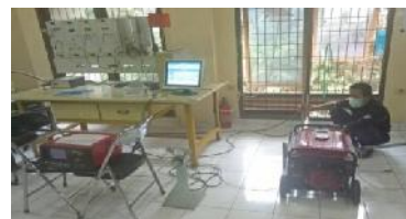
Gambar Instalasi Stargas 898 Tampak Belakang
