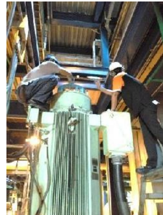
Gambar 4.8 Proses penambahan Trial Weight (TW) pada coller fan rotor motor CP 3A
